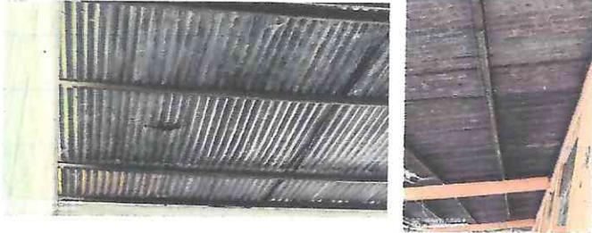
Foto1: Techos en mal estado de las aulas de Perito Contador y cambio de estructura de metal y Canales
