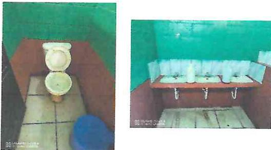
Foto 5: Reparación de Baños, cambio de sanitarios y de Azulejos y repuestos
